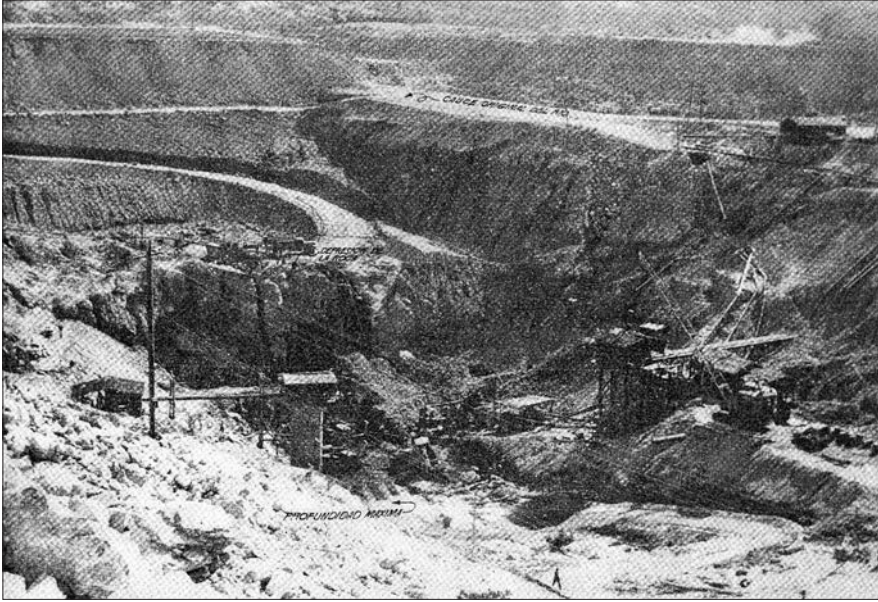
FIGURA 5 TRABAJOS EN LA PRESA OVIACHIC, 1955
