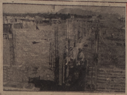
He aquí la forma en que han avanzado las obras de construcción de la escuela primaria que el Club 20-30 Internacional construye en el Barrio de Las Ladrilleras...
