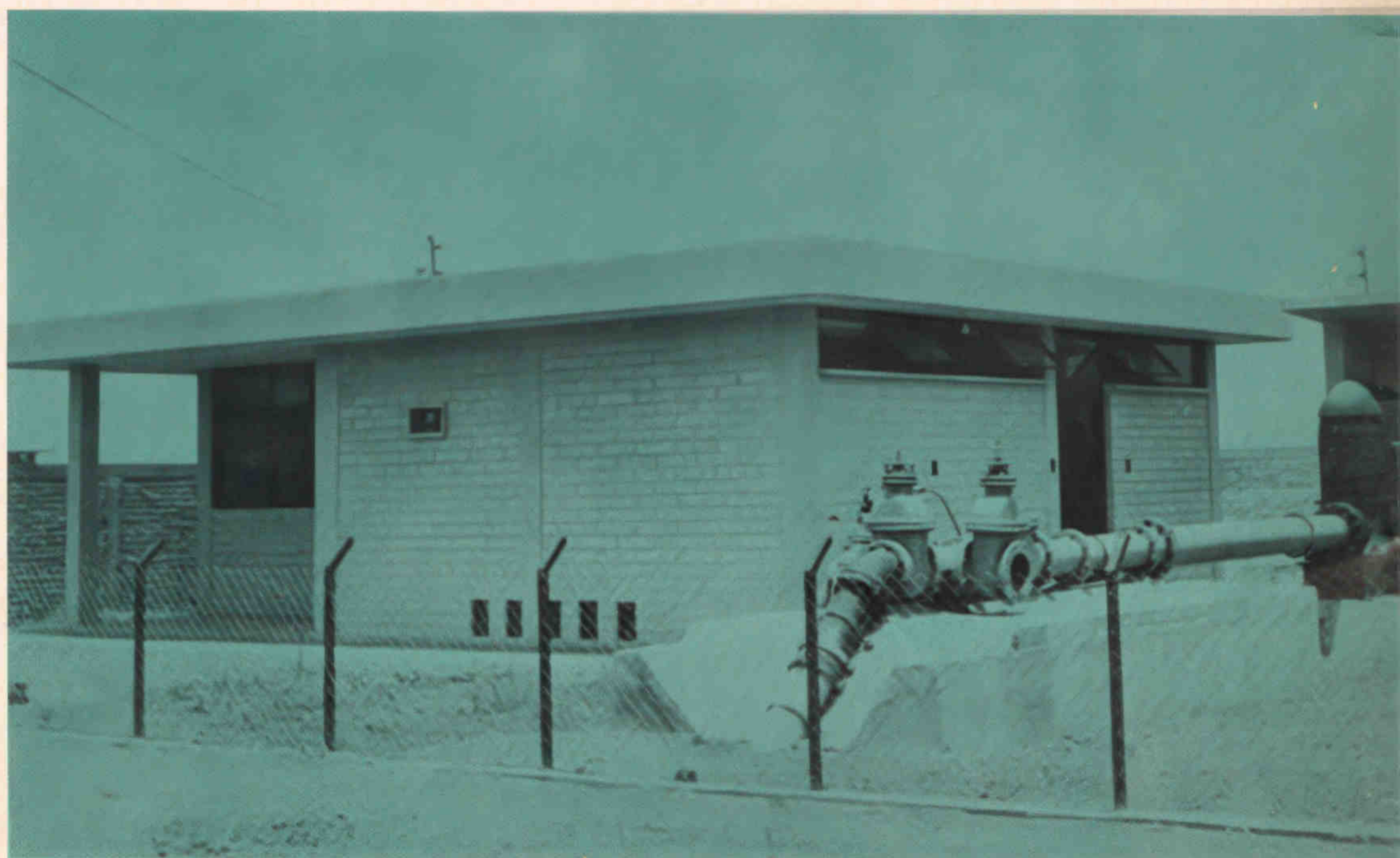
Para la introducción del Agua Potable a la comunidad, la institución local aportó 129 mil pesos.
