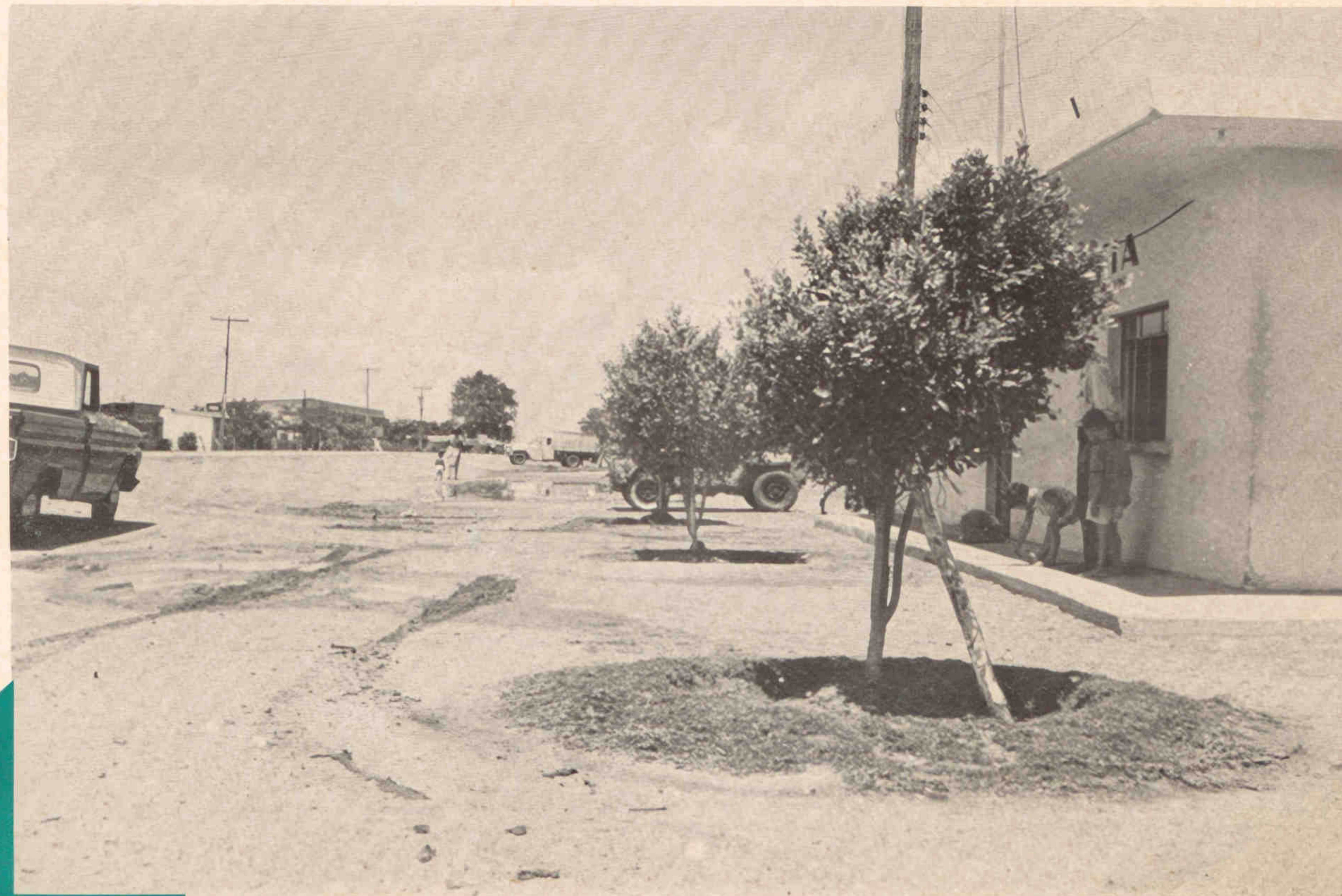
El Comité cooperó para la reconstrucción del edificio de la Delegación de Policía, (en primer término), paga alumbrado público, acogió la campaña de forestación y se hizo cargo del riego y el arreglo de las calles.
