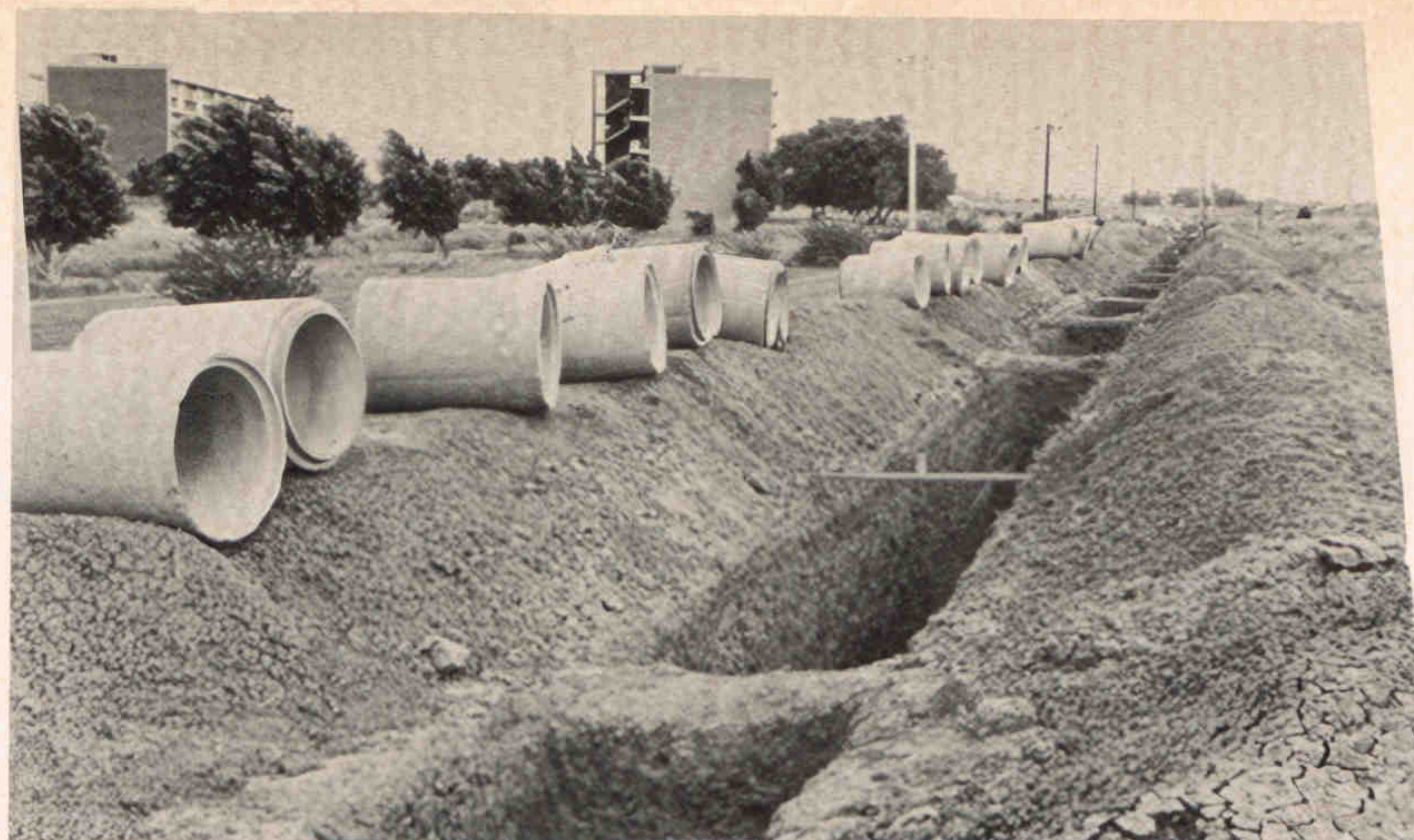
Preparación de la zanja para la colocación de tubería de concreto, de 76 centímetros de diámetro. Obras del colector de alivio, a la altura de los edificios multifamiliares.
