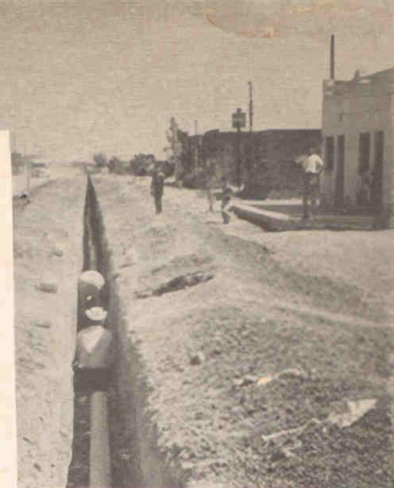
Barriadas alejadas como las colonias Cuauhtémoc y Morelos - La Ladrillera- que sufrían la falta de agua potable, han sido ya atendidas. En las gráficas se puede apreciar la colocación de tubería de asbesto cemento, de 6 pulgadas. El crecimiento de la ciudad y el aumento de los habitantes crearon problemas en el aspecto de agua y saneamiento.
