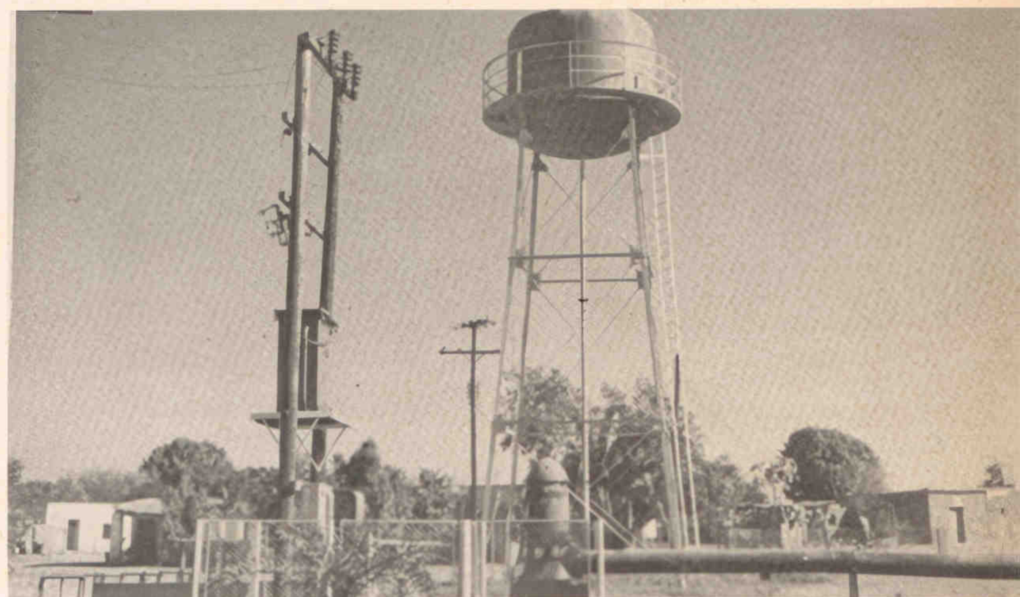
El poblado tiene ya agua potable y energía eléctrica. El Comité ha cooperado en toda obra de bien común.
